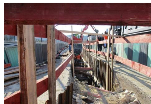
Les travaux du réseau de chaleur ont démarré le 20 février à proximité du SIETREM. ©CAMG
