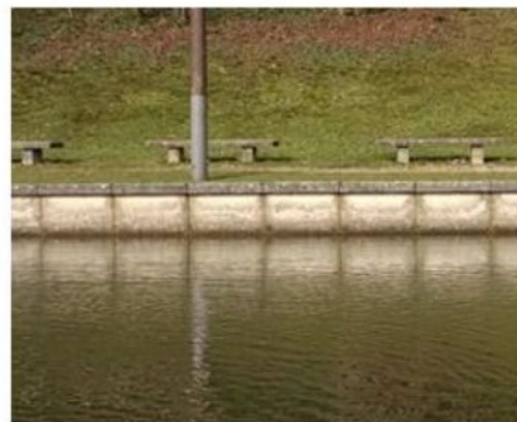
Berge de type 1 - minérale
