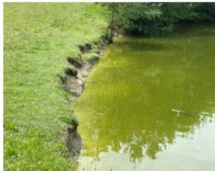
Berge de type 2 – Naturelle avec érosion marquée
