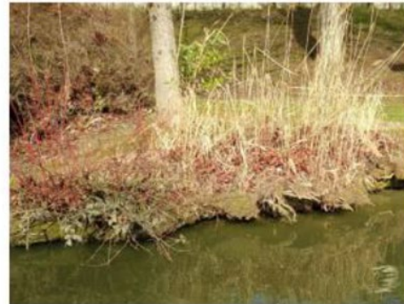
Berge de type 3 – Naturelle avec un léger affouillement
