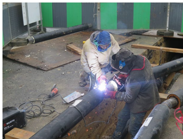
Soudure des sections de canalisation
