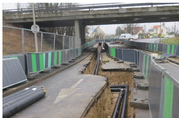
Sous la D934 en haut de la côte Saint-Laurent
