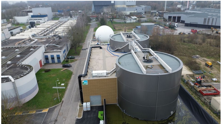
L'unité de méthanisation : au premier plan les digesteurs et au fond le gazomètre. À gauche, l'usine d'épuration des eaux usées
