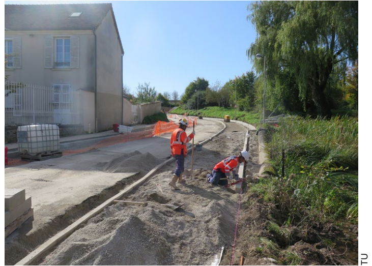
Boulevard du Pavé de Fontenelle à Bussy-Saint-Georges
