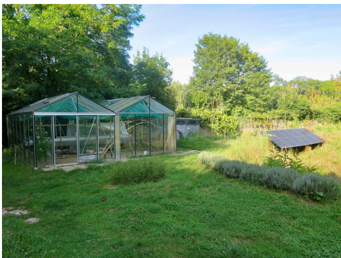
Les serres à plants avec à droite le grand panneau solaire qui l'alimente.
