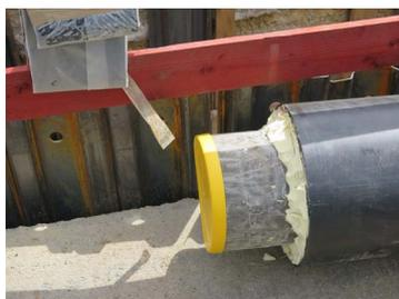
*Un tronçon de canalisation avec son isolant thermique*
