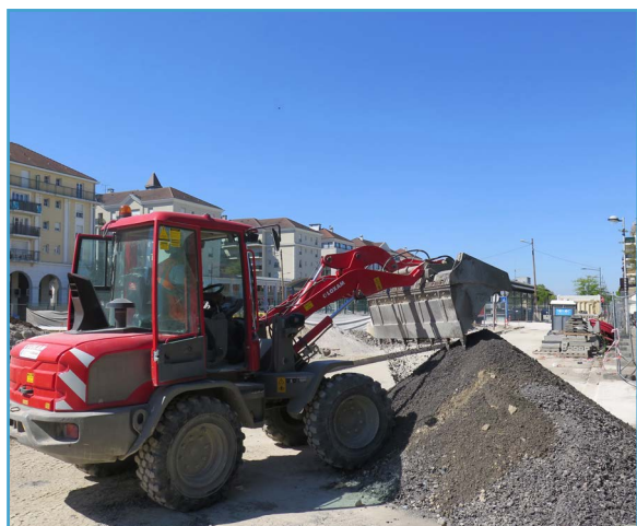
Un nouveau parvis pour la gare de Bussy-Saint-Georges
